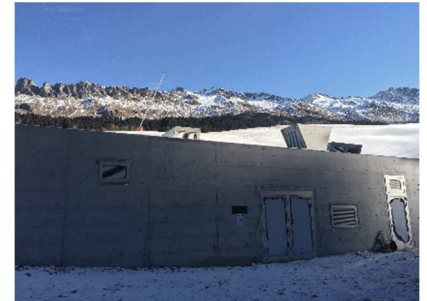
Bild 1: Außenansicht der Pumpstation
